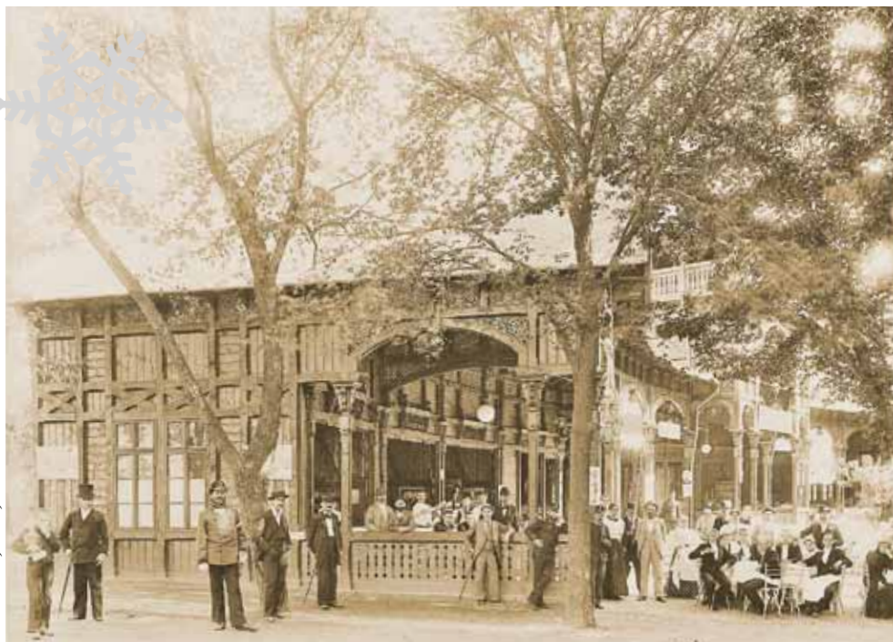
A városligeti millenniumi kiállításon még sörköstoló pavilonként üzemelt épület korcsolyafelkötő-öltözőként, büféként, illetve zenekari teremként lett újjahasznosítva új helyén. A felvétel 1896-ban készült
